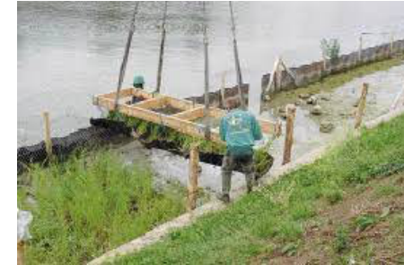
Berges en génie Végétal Bonneuil
