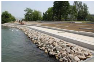
Parc du Rhin Tortu-Lollier quai enroché
