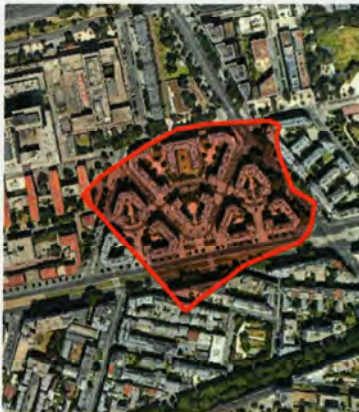
Ensemble d'immeuble HBM Boulevard Ney PARIS
