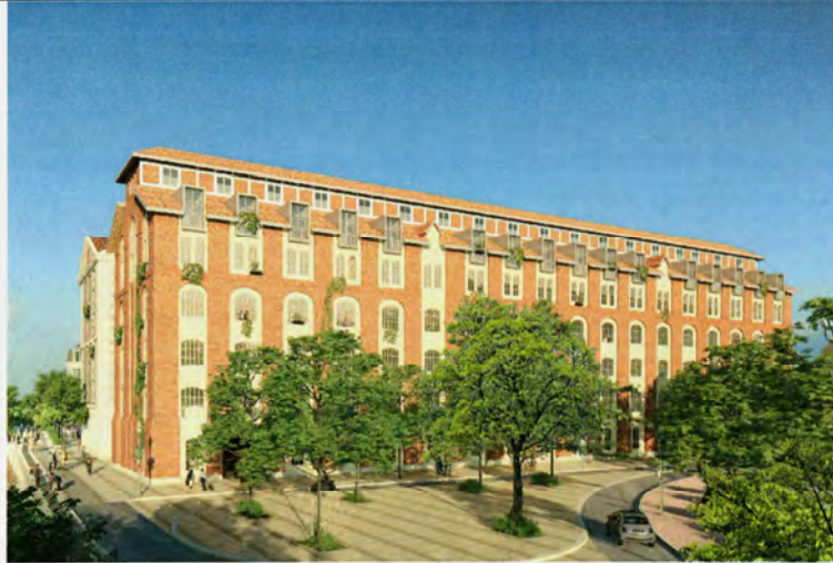
Vue depuis le Quai de l'Apport Paris
